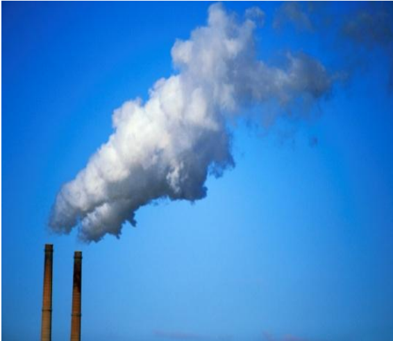
Imagen 8. Central eléctrica. Fuente Galería imágenes Google.
