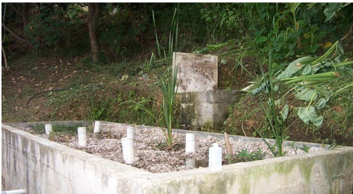
Figura 4. Humedal de Flujo Subsuperficial
